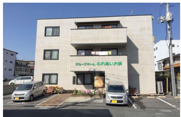
グループホームふれあい大須(安芸郡府中町)
